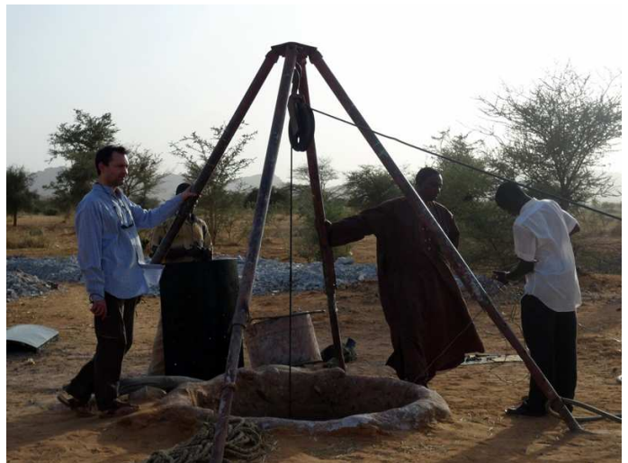
Travaux du puits de Ferro
