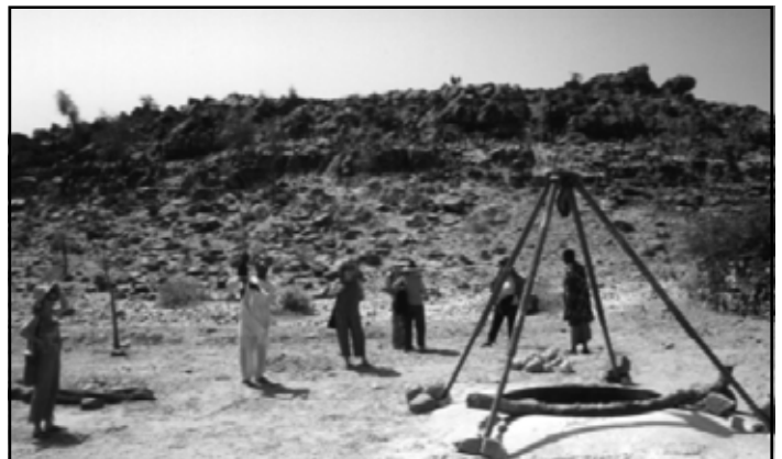
Le puits de Siba en construction
